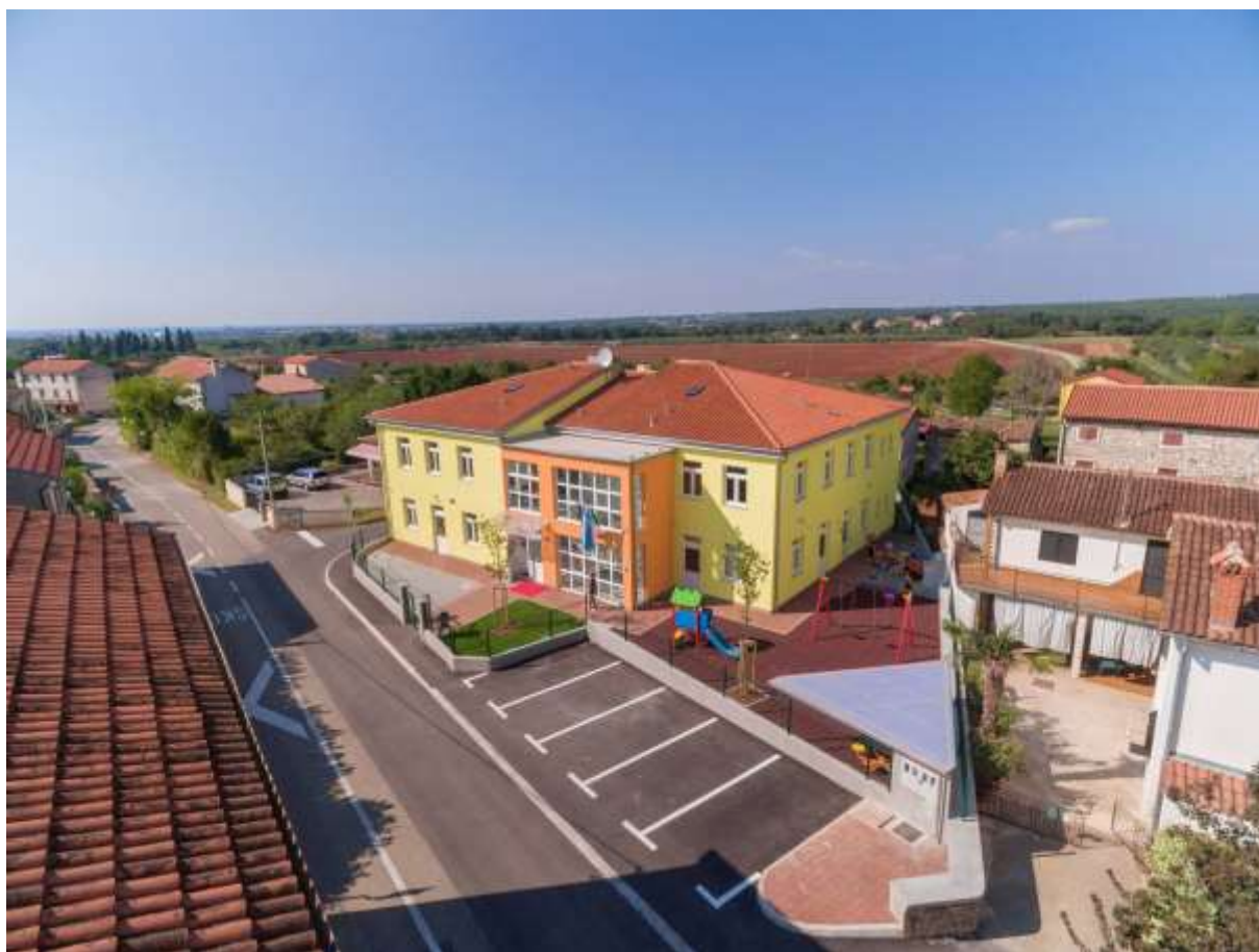
Slika 1 Izgradnja područne OŠ i vrtića Petrovija
