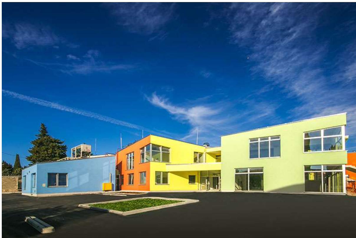
Slika 3 Izgradnja dječjeg vrtića Radost-Komunela
