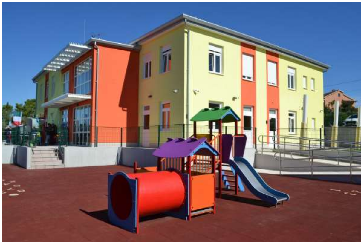
Slika 4 Izgradnja područnog dječjeg vrtića u naselju Murine
